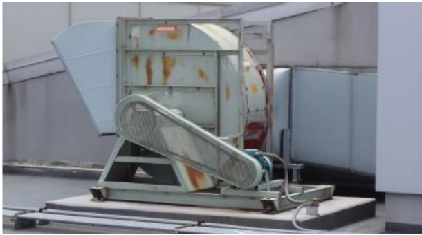
รูปที่ 11 เครื่องดูดควันไฟในกรณีเกิดเพลิงไหม้
